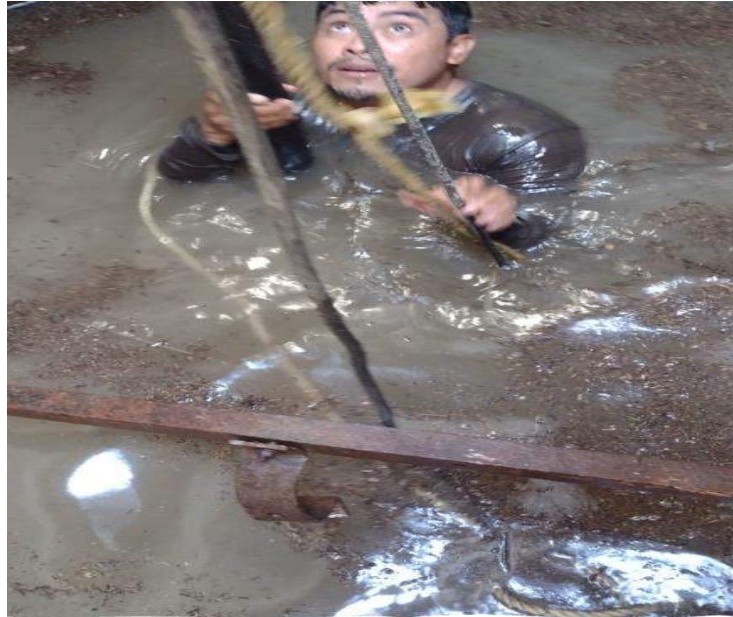
Figura 18. Maniobras para desensamblar la bomba del depósito de agua del pueblo.
