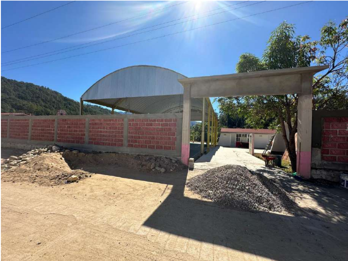
Figura 9. Escuela en construcción
