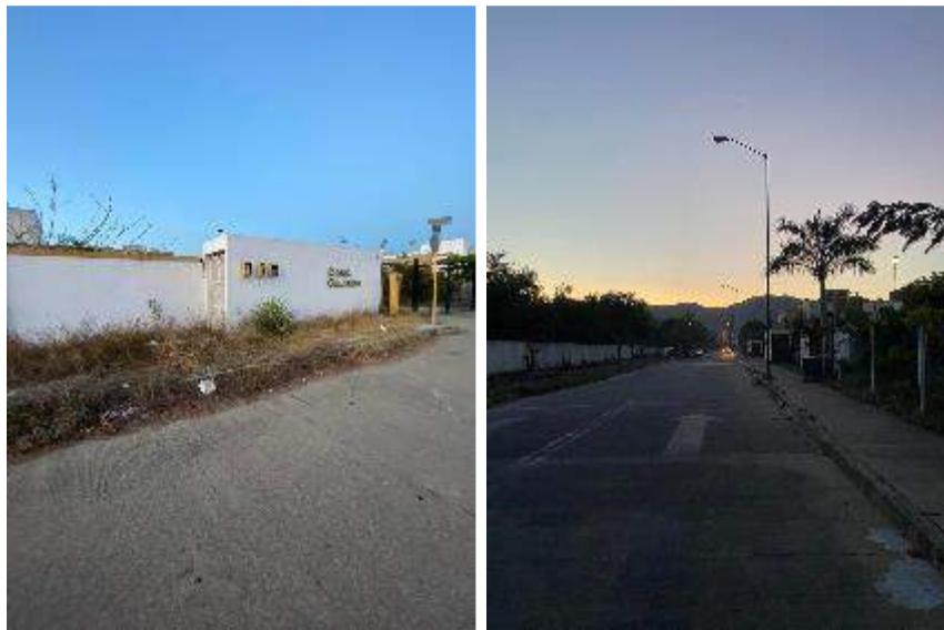
Ilustración 38. Alumbrado público y áreas verdes en la avenida perimetral del fraccionamiento. Fuente: Propia.
