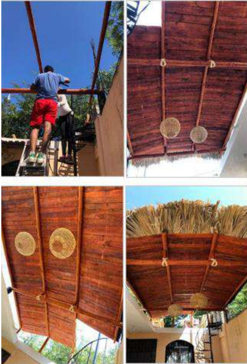
Figura 42. Elaboración de un techo de madera con hojas de palmas.
